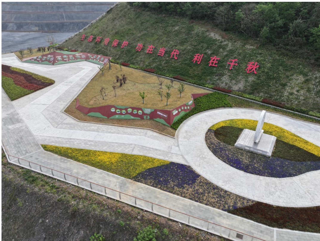
照片 2-2 本矿区已复绿边坡、平台（观景平台）
