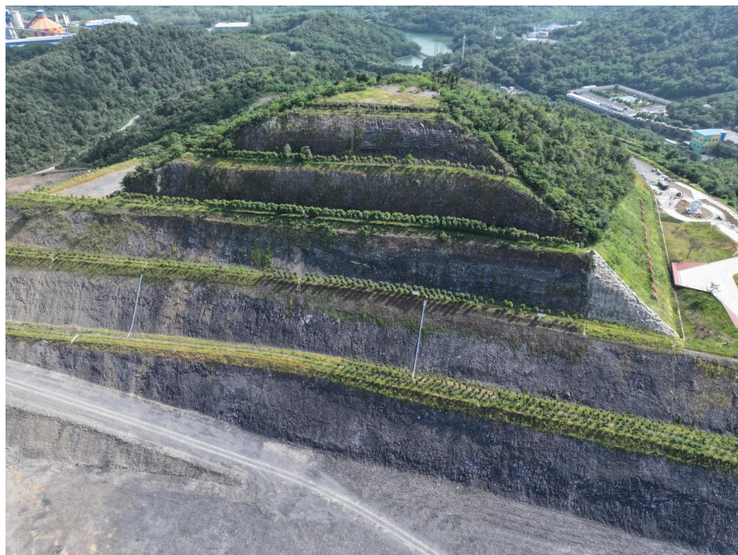
照片 2-4 本矿区已复绿边坡（南侧边坡）
